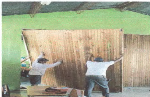
Foto 1: Inicio de sustitucion de porton de madera
