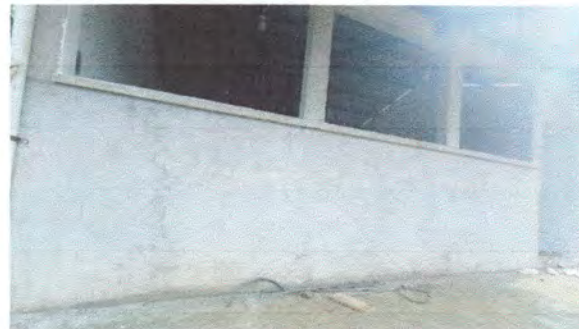
Foto 4: preparacion para colocar los ventanales.
