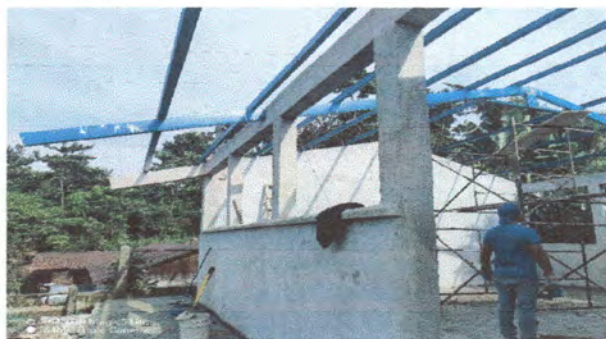
Foto 3: Cambio de lamina en el modulo I Aula
